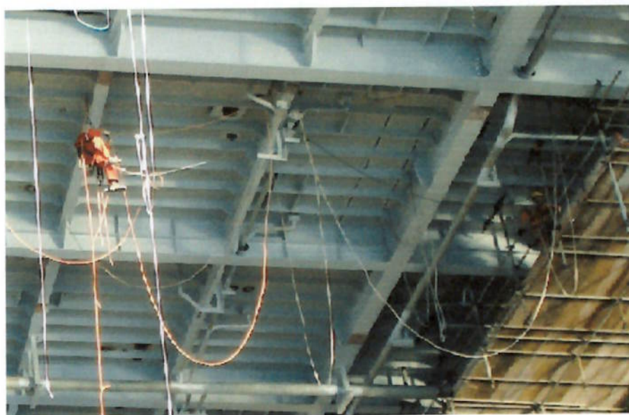
Fig.14 – Exemplo de progressão horizontal com utilização de vários tipos de ancoragem em plataforma
