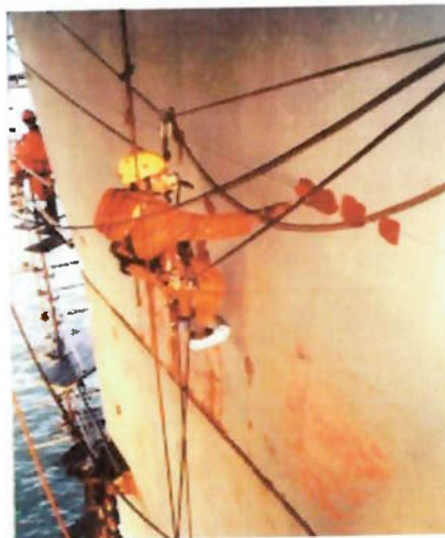
Fig. 18 - Trabalho de pintura em coluna de plataforma
