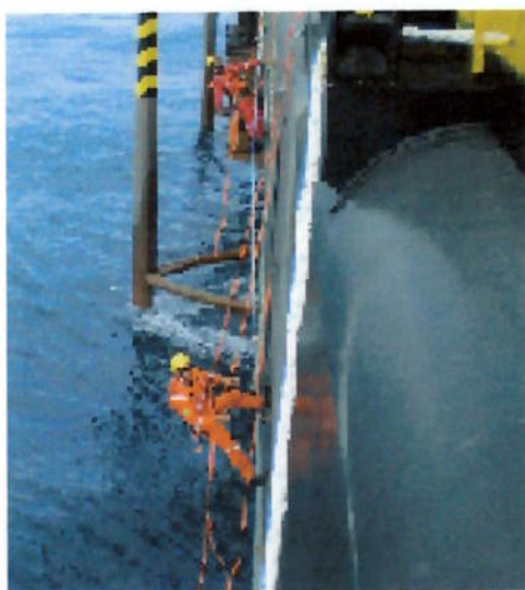
Fig. 6 - Equipe com supervisor remoto no costado da plataforma P-48
