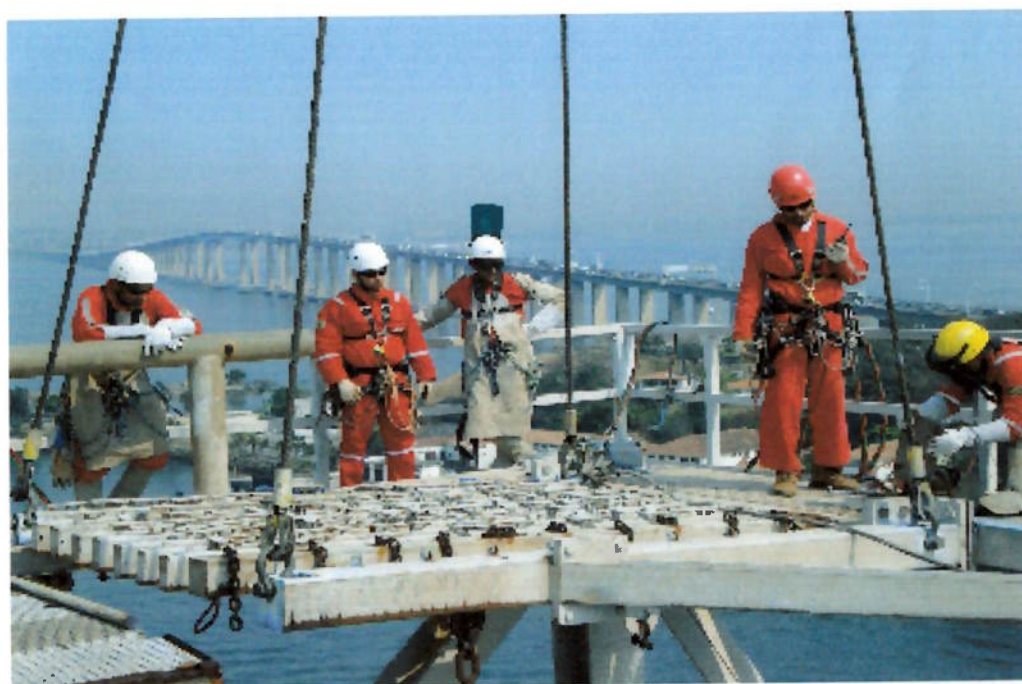
Fig. 15 - Equipe com Supervisor no desmonte da torre de 75m e 172 t da plataforma Olinda Star
