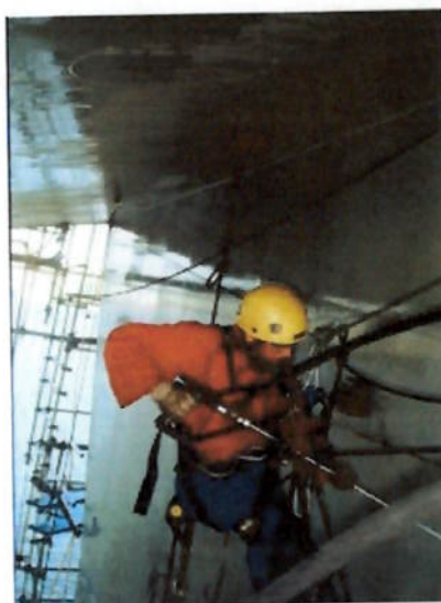
Fig. 19 – Trabalho de hidrojateamento em estrutura de plataforma
